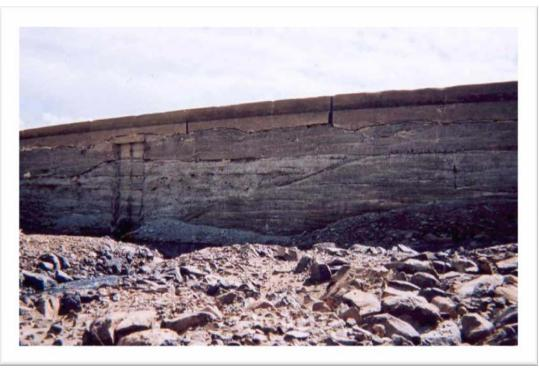
FIGURE 6-14. SPALLING AND CRACKING ALONG UPSTREAM FACE OF ALBION DAM<sup>58</sup>
